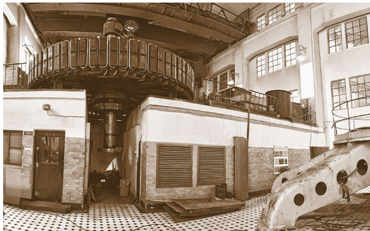
Волховская ГЭС. Замена рабочего колеса
